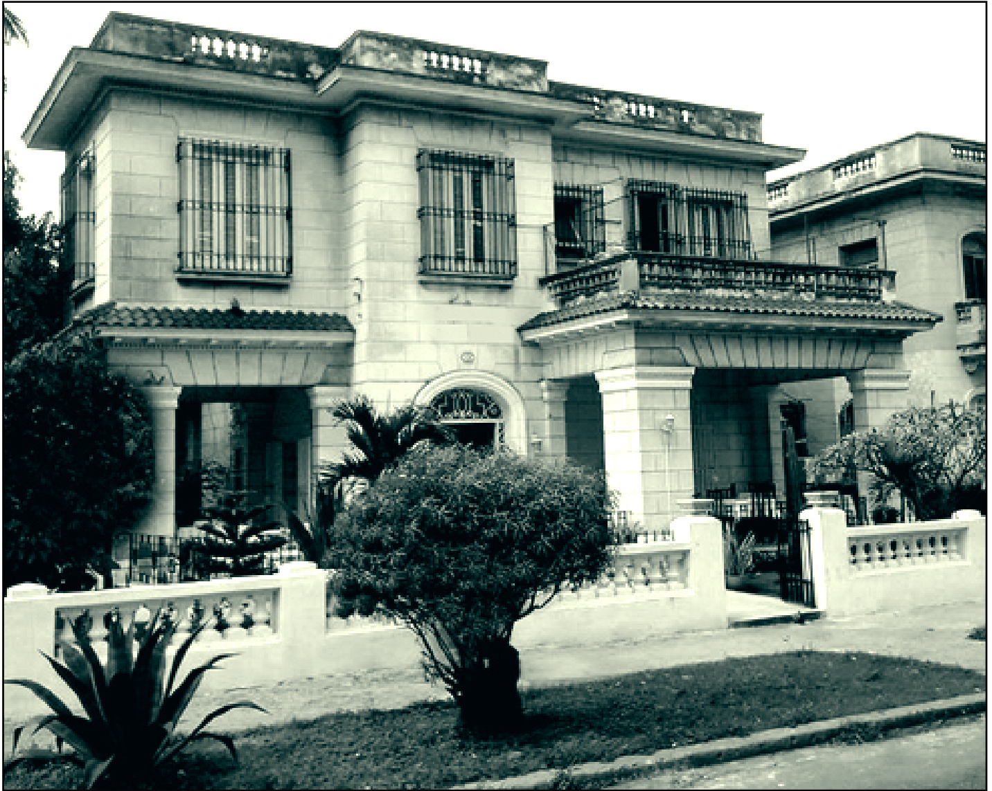
Casa de Mendieta en el Vedado, en la calle 19 número 111
